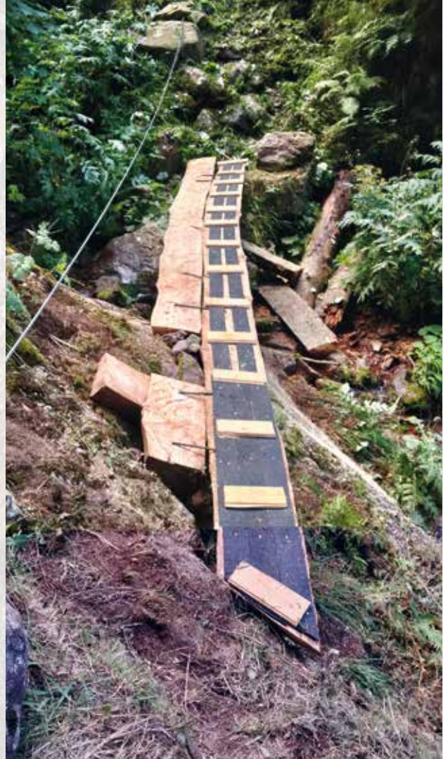
▲ Sentiero 750 - Ponte Val Càvena dopo
